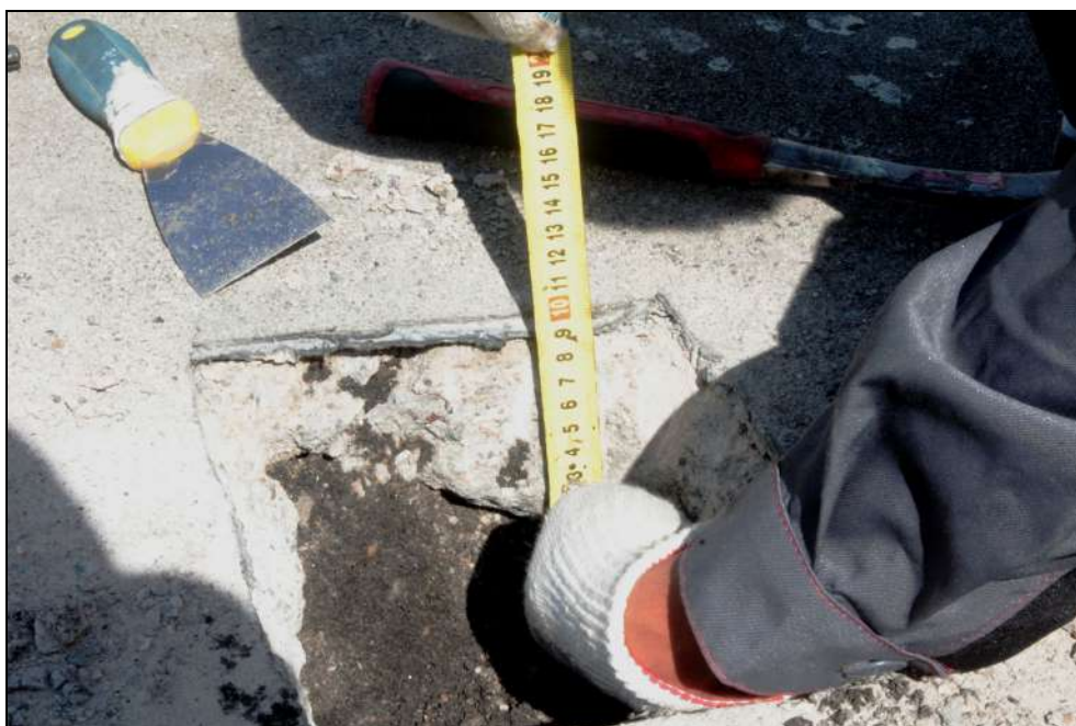
Рисунок 10. «Г-Д»/«9-10» Толщина бетонного основания кровли \leq 86 мм.
