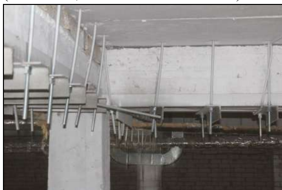
Рисунок 2. Усиление конструкций каркаса согласно проекту ТОО «Караганда Техно Сервис».
